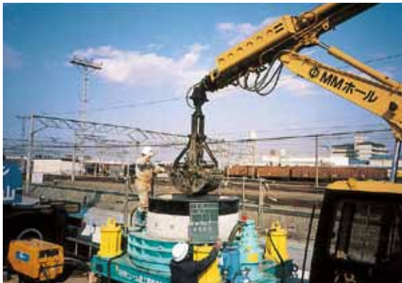
③ 掘削、圧入状況
