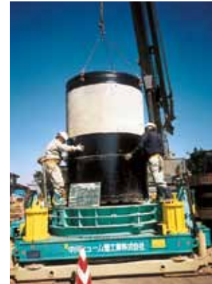
② 刃口、側塊設置
