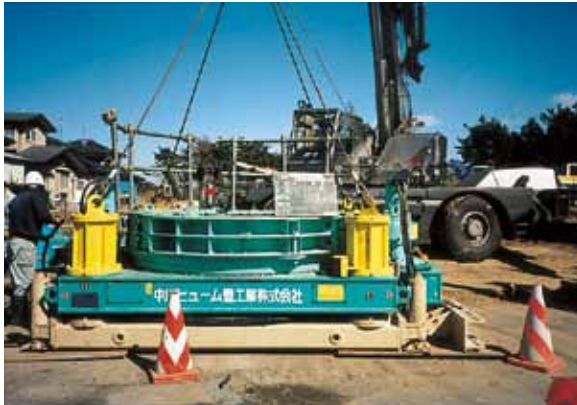
① 圧入機据付設置
