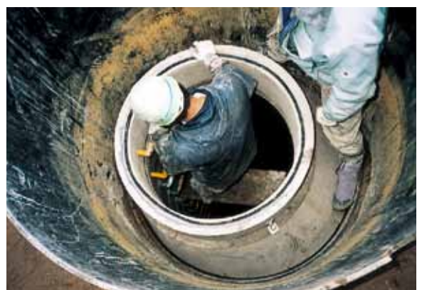
⑧ 人孔設置
