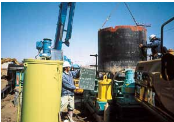
⑤ 仮設ケーシング据付
