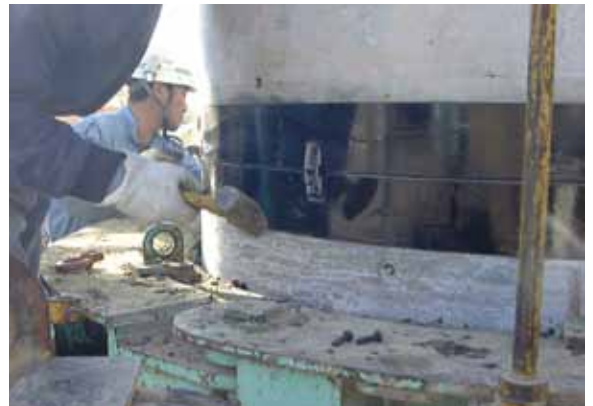
④ 側塊接合状況
