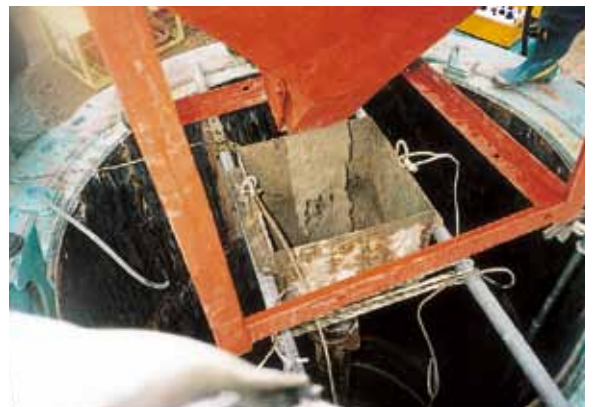
⑥ 底版コンクリート打設
