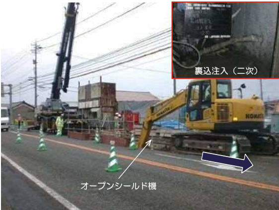
6 敷設函体上部埋戻し
