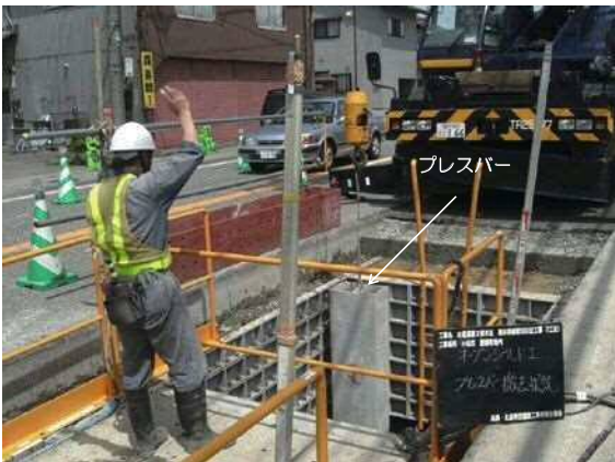
8 函体緊結(PC鋼棒縦締め緊結)
