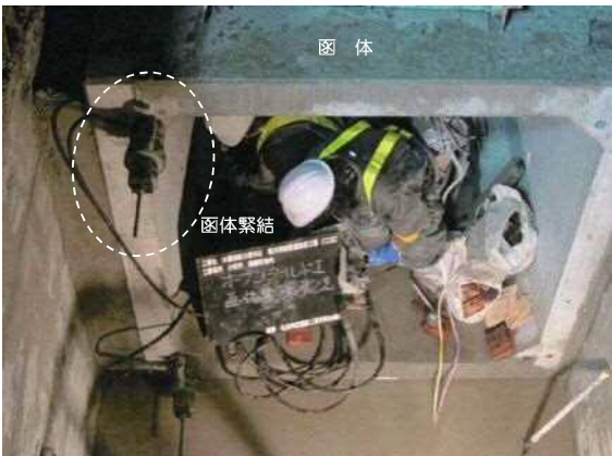
8 函体緊結(PC鋼棒縦締め緊結)
