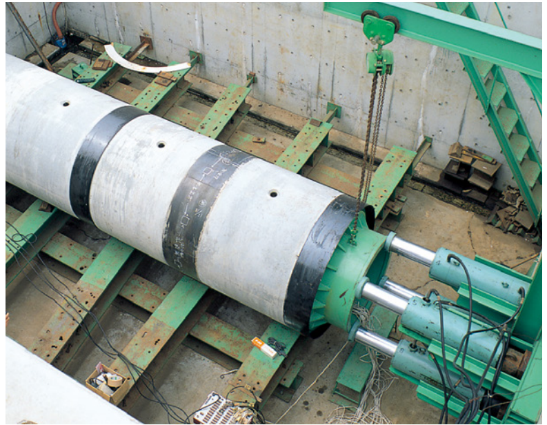
推進用大変位CSパイプ 軸力試験
