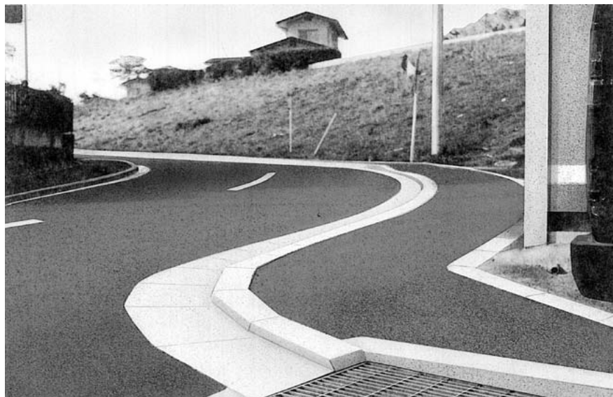
斜切CSBを用いた布設
