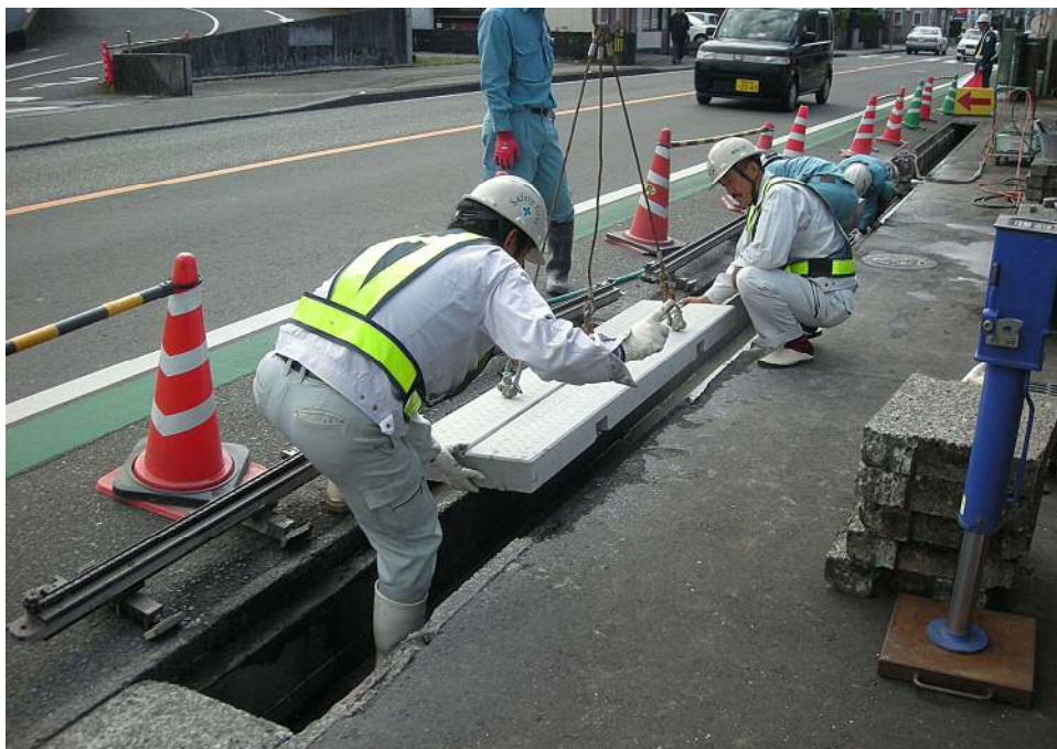
本郷南方 側溝蓋リリニューアル工事 (W2Rカッターによる既設側溝の切断)
