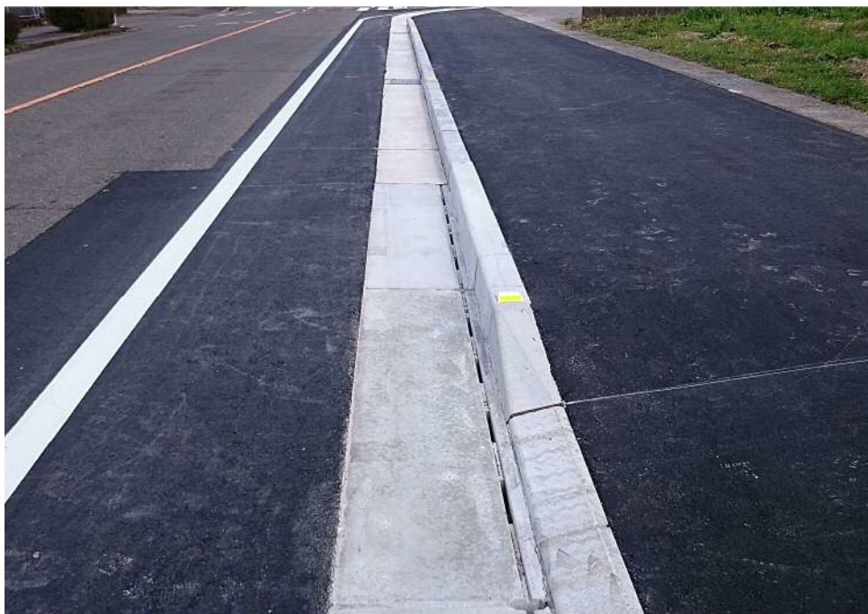
えびの市 原田排水路 かんたん側溝1000×900-1500 (可変型)
