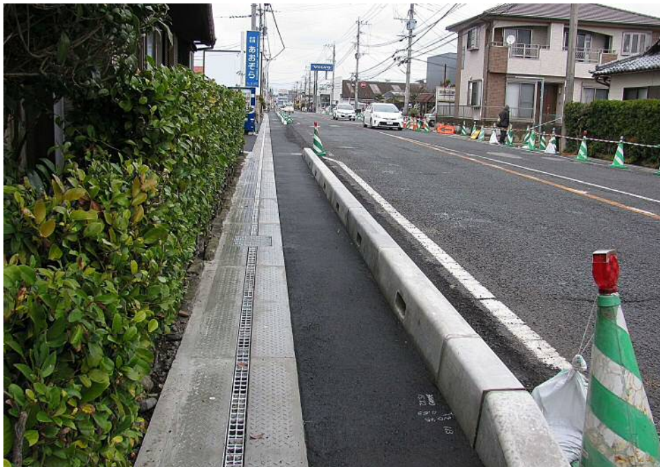
宮崎市芳士 側溝蓋改修工事 かんたん側溝蓋FG300・400
