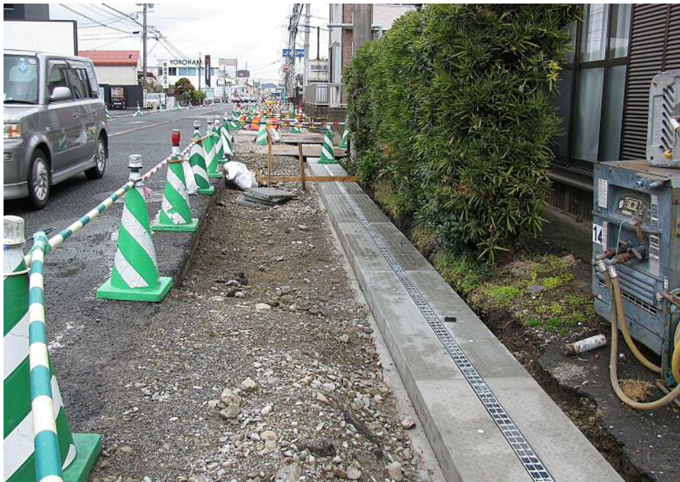
リニューアル側溝蓋（かんたん側溝FG使用） 宮崎市芳士
