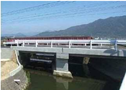
CTGスラブを使用した簡易橋梁
