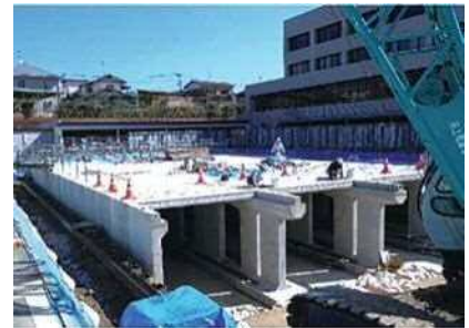
CTGスラブを使用した貯留施設上蓋
