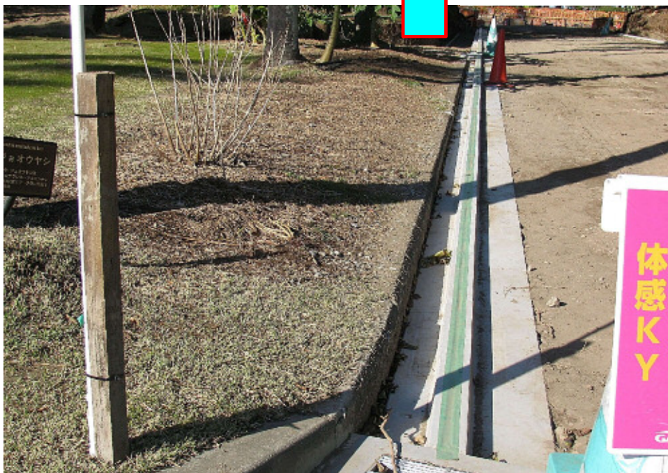
縁石を乗せずに歩車反転して使用した状況
