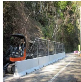
切土工事に仮設で設置
