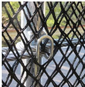
ネットの接続部は支柱のロープガイドに引っ掛けて設置
