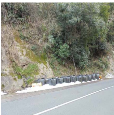
施工前：大型土のう
