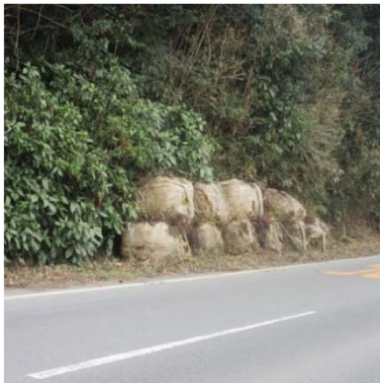
施工前：大型土のう
