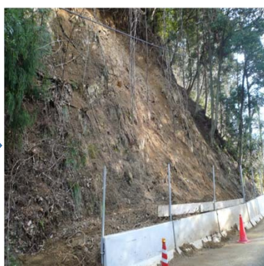
施工後：崩壊土砂を捕捉
