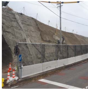
のり面工事に仮設で設置
