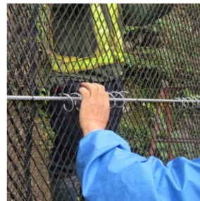
ネットジョイント設置
