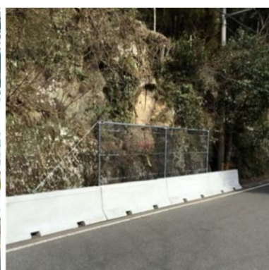
岩盤の剥離箇所に設置
