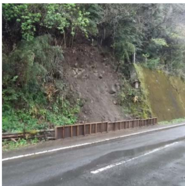
施工前：崩壊現場に仮設の木柵
