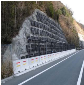
基礎擁壁に反射板設置
