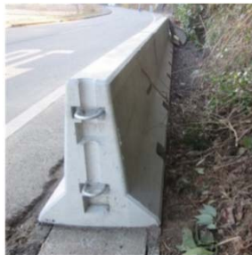
基礎擁壁の側面
