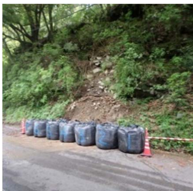
大型土のう対処事例
