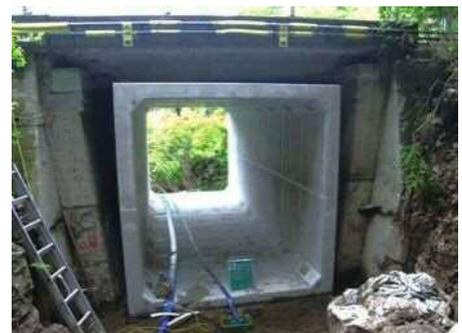
橋梁補修例 (BOX引込み隙間を充填)
