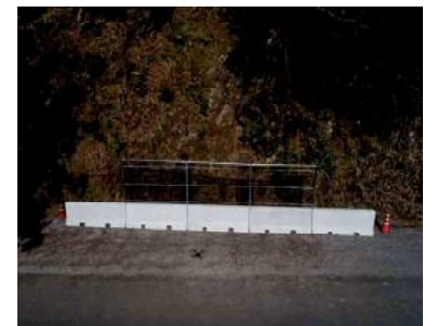
施工後 (上から)
