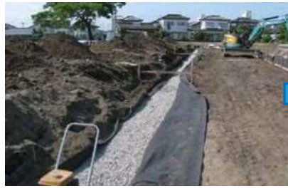
浸透側溝 施工例
