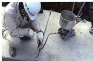
注入口より側壁部・底板部へ注入
