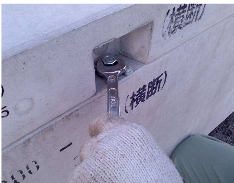
スパナにて増し締め 完了 ボルト部分は無収縮 に外詰め込み
