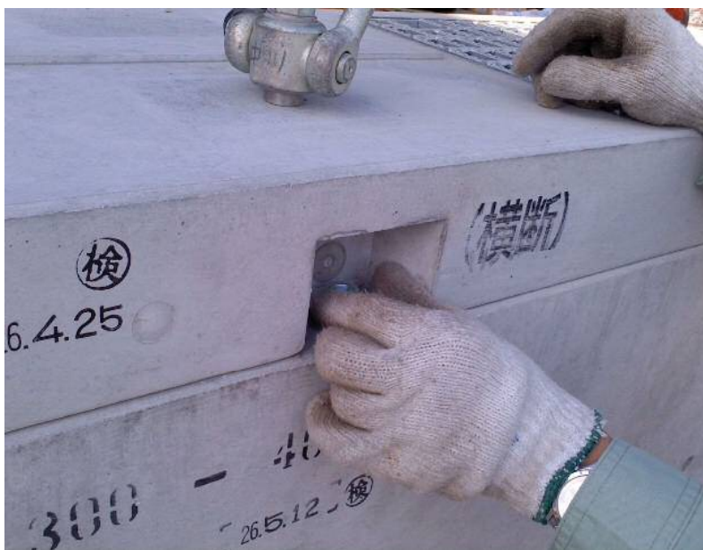
寸切ボルトへナット取付
