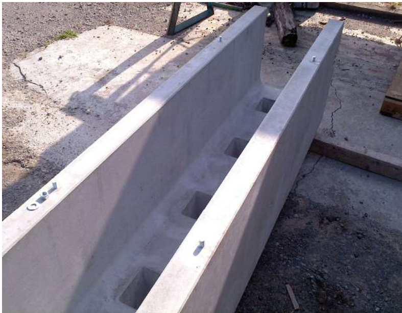
寸切ボルト取付完了
