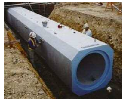
大型CSB施工状況
