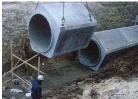
ペンタ・ボックス施工現場
