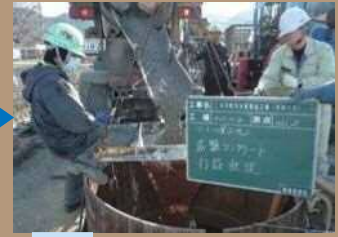
ベースコンクリート打設
