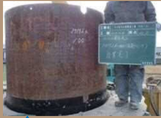
仮設ケーシング据付
