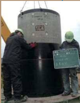
刃口、側塊設置
