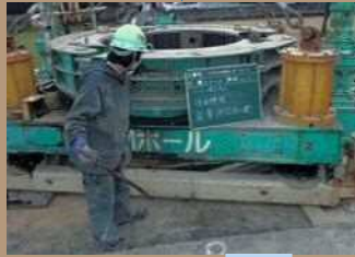
圧入機据付設置
