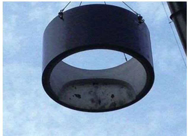
鋼板とコンクリートを合成させた製品 (削孔径が規格以上の時などに使用)
