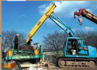
掘削、圧入状況
