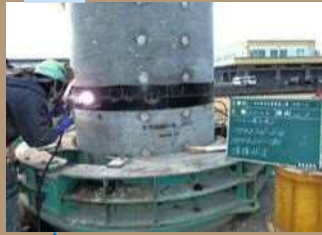
側塊溶接状況
