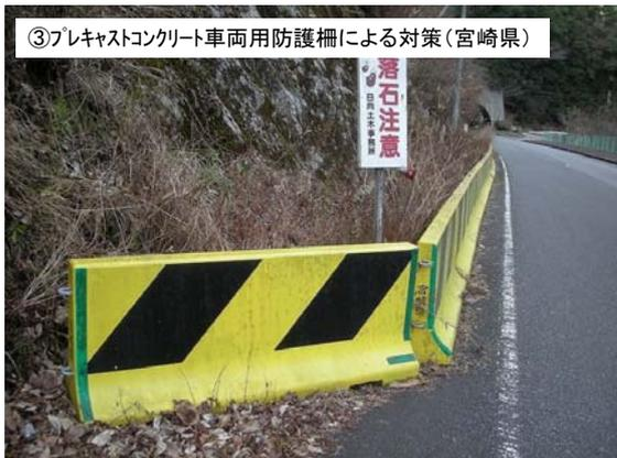
④プレキャストコンクリート車両用防護柵による対策(宮崎県)
