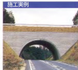
滋賀県・一般農道甲賀中部地区
