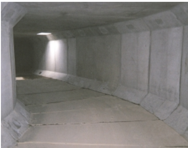
PCボックスカルバートカーブ施工
