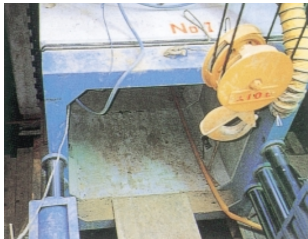
PCボックスカルバートによる推進工法
