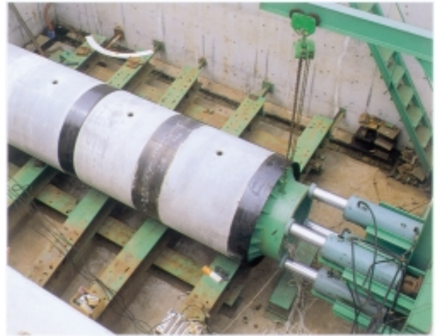
推進用大変位CSパイプ 軸力試験
