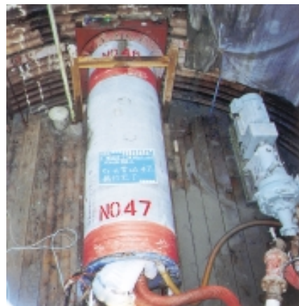
NS推進管φ800×2.43の推進状況
