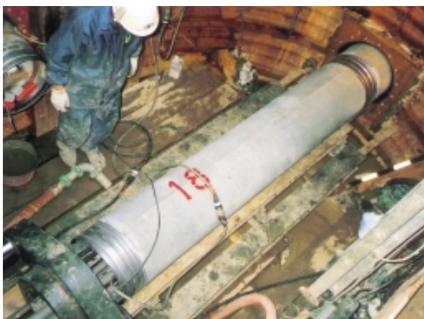
小口径NS推進管推進状況 (φ300×2,000)
